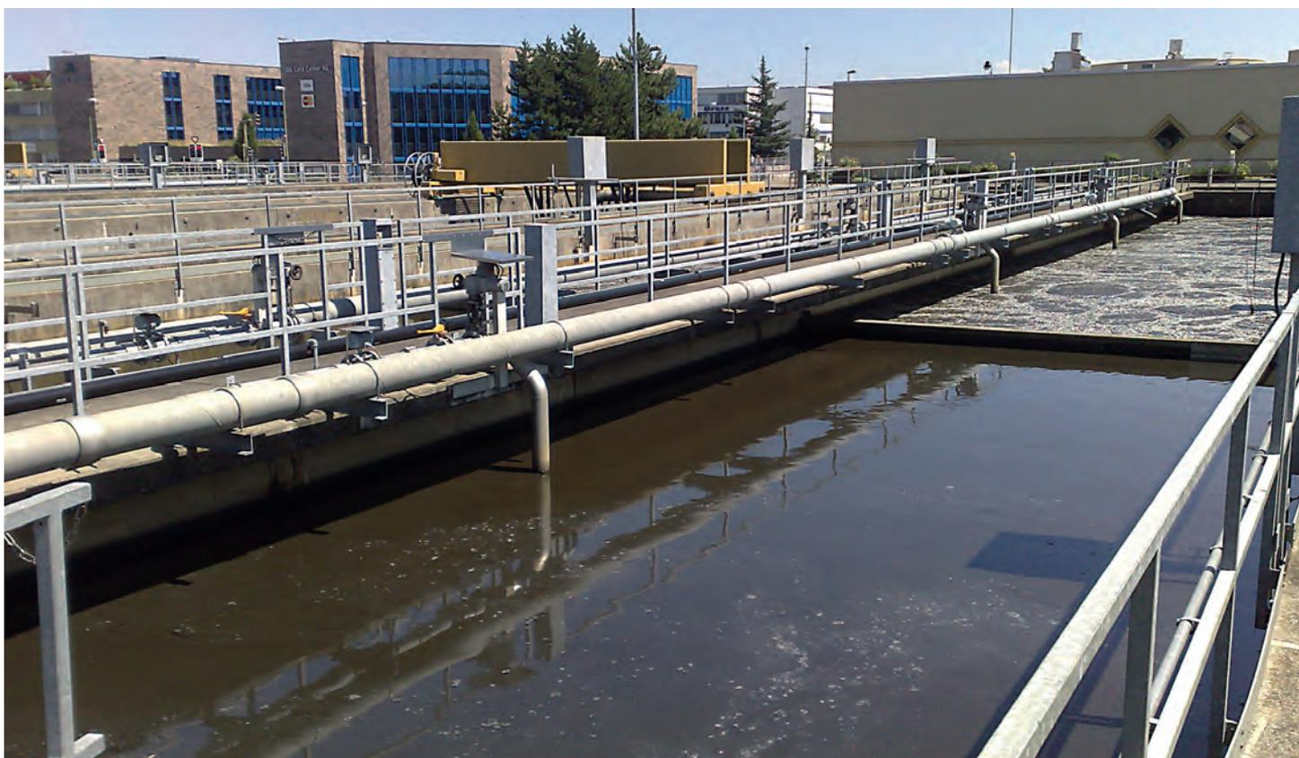
Vue du bassin de traitement biologique de la STEP de Kloten-Opfikon (ZH) pendant l'essai pilote d'élimination des micropolluants à l'aide de poudre de charbon actif. Les boues activées, normalement brunes, apparaissent noires ici en raison du recours à ce processus spécial.
