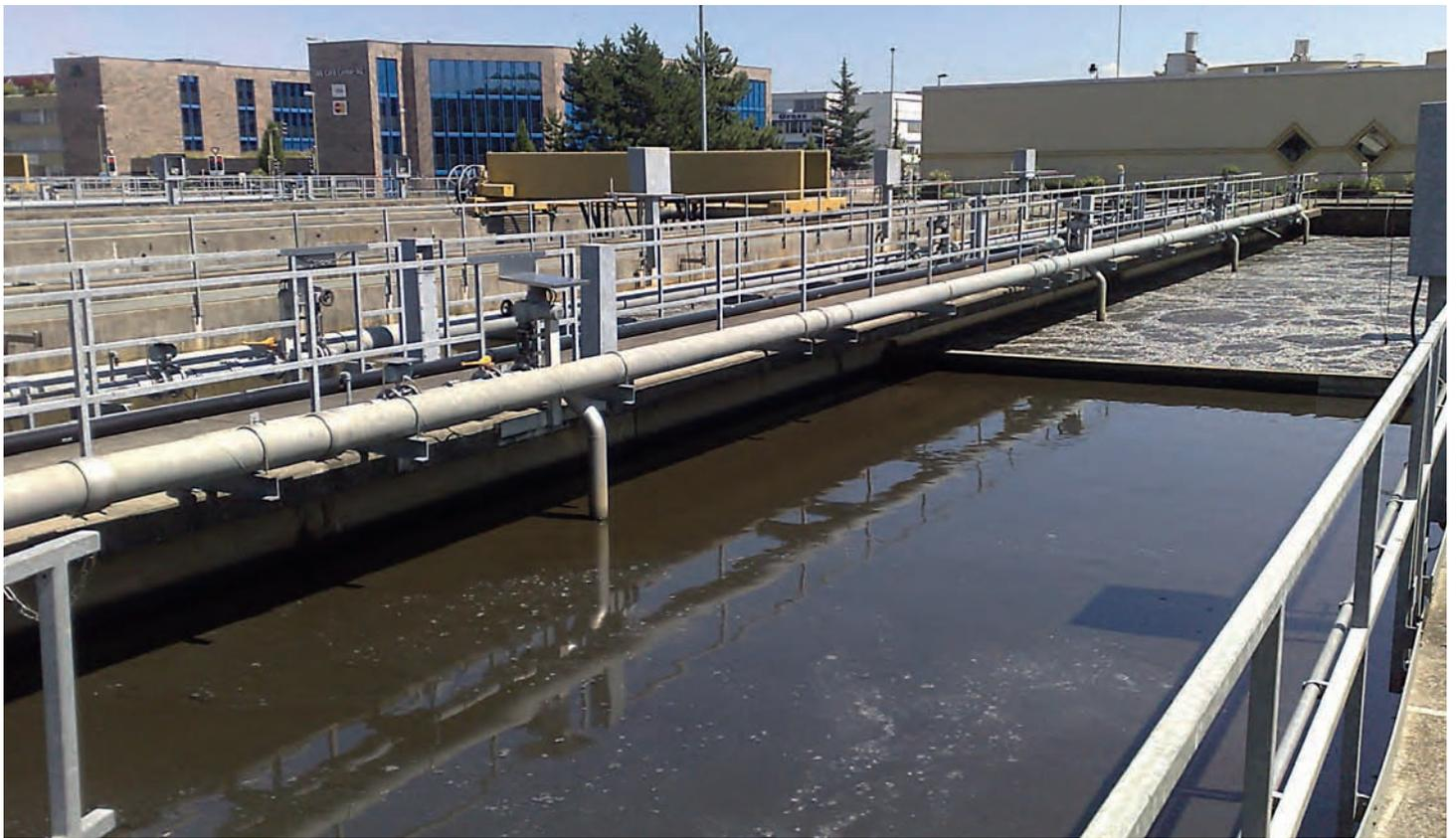
Die biologische Reinigungsstufe der Kläranlage Kloten/Opfikon (ZH) während des erfolgreichen Pilotversuchs zur Elimination von Mikroverunreinigungen mittels Pulveraktivkohle. Durch den Einsatz dieses Verfahrens ist der normalerweise braune Belebtschlamm hier schwarz gefärbt.
