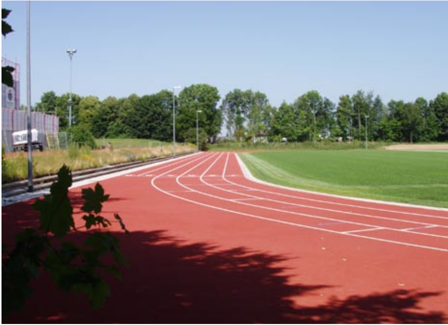
Eine gute Laufbahn ist extrem strapazierfähig und UV-resistent. Laub sollte aber abgeblasen werden, Moose werden per Grundreinigung entfernt. Bild: Brinkmann + Deppen
