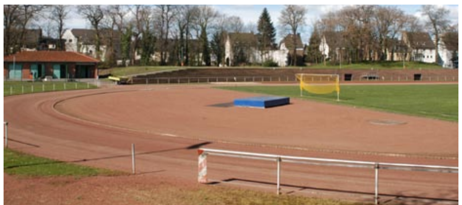
Vorher: Tennenbelag im städtischen Stadion
