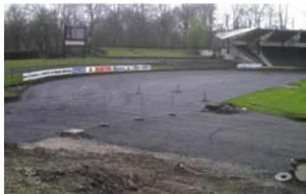
Der Asphalt wurde vorbereitet, jetzt kommt die Laufbahn Bild: Stadionwelt
