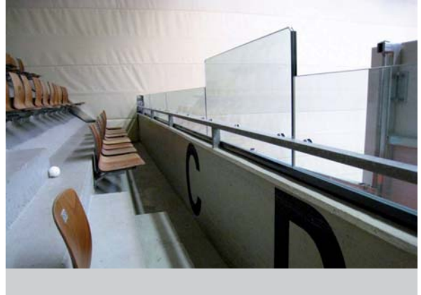
Abbildung 35 Absturzsicherung aus Verbund-Sicherheitsglas, das im Bereich der Treppe erhöht wurde
