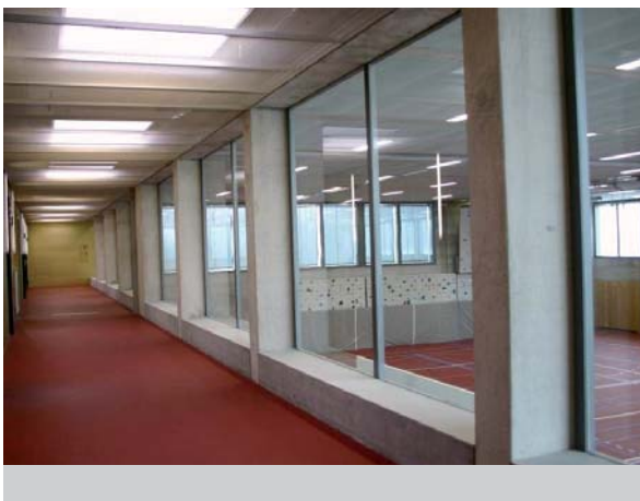
Abbildung 17 Verbund-Sicherheitsglas bei Absturzgefahr
