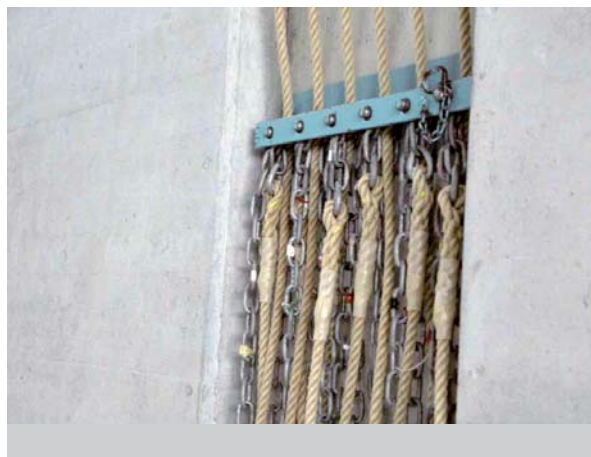
Abbildung 10 Minimalanforderung: offene Nische für Seilzüge
