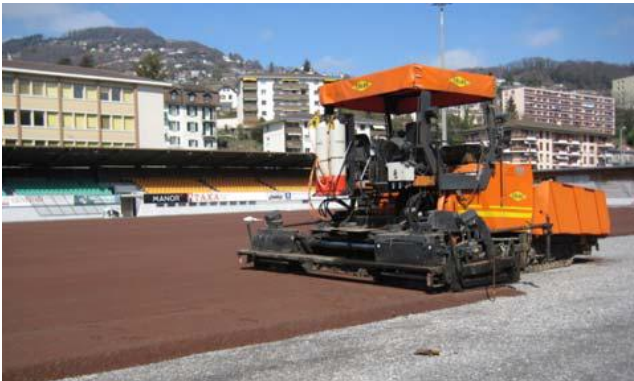
Die Vulkanerde wird eingebaut (links), danach wird darüber der Kunstrasen verlegt (rechts)
