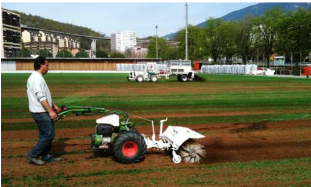
Der Kunstrasen wird mit organischen Elementen aufgefüllt (links), danach wird angesät (rechts)
