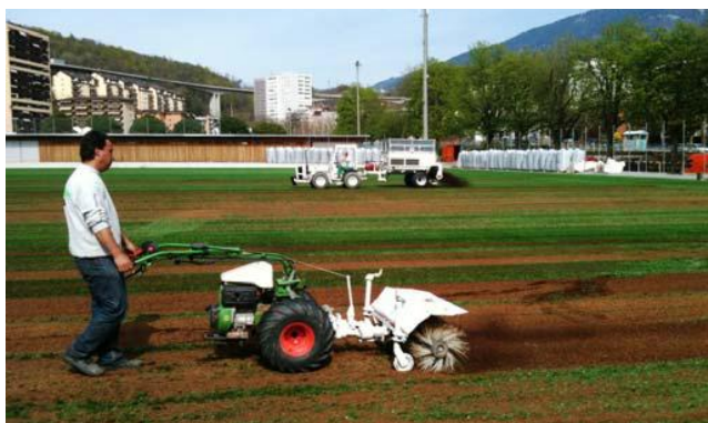
Remplissage du gazon synthétique avec des matériaux organiques et l'ensemencement
