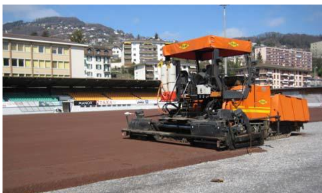
Pose du support en terre volcanique et par dessus le gazon synthétique
