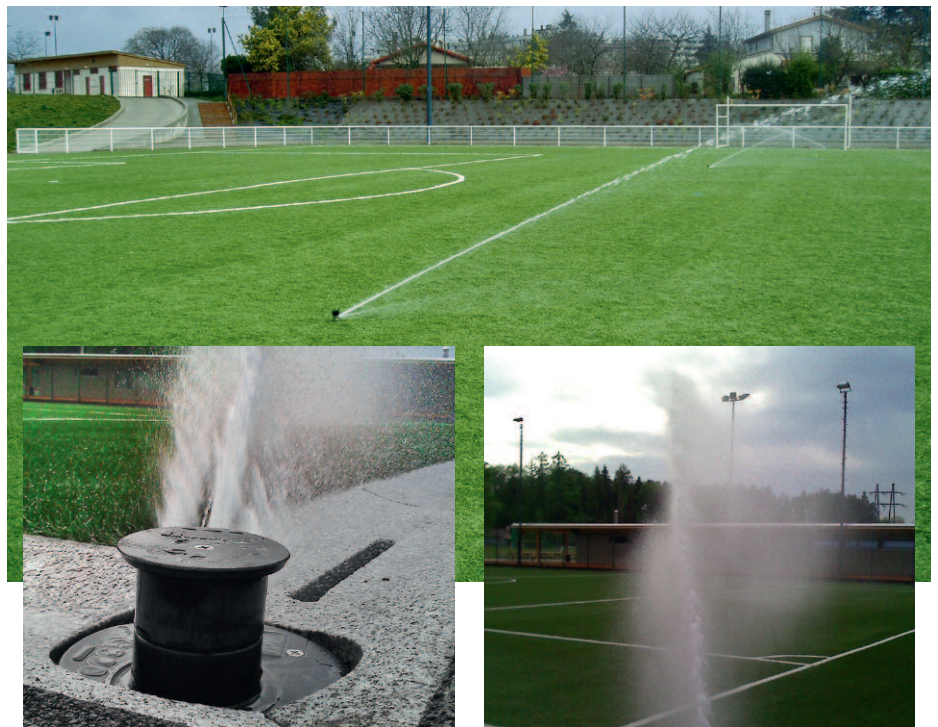
Idealerweise wird ein Kunstrasen mit einer fest installierten, unterirdischen Bewässerungsanlage ausgestattet. (Bilder: Hirt Walter AG und Hunter Industries)
