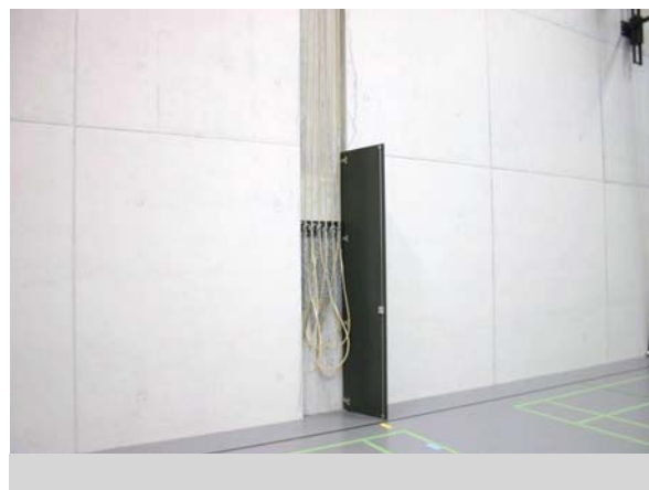
Illustration 13 Couverture montée ultérieurement, fixée avec des bandes velcro
