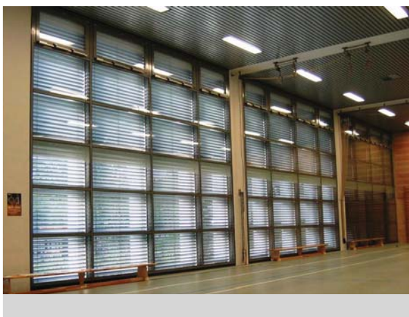
Illustration 20 Exemple d'une façade de fenêtres fermées
